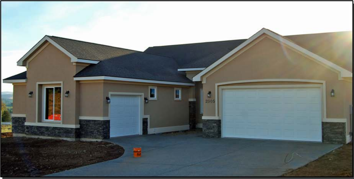
House #12 - DH Construction & Development
